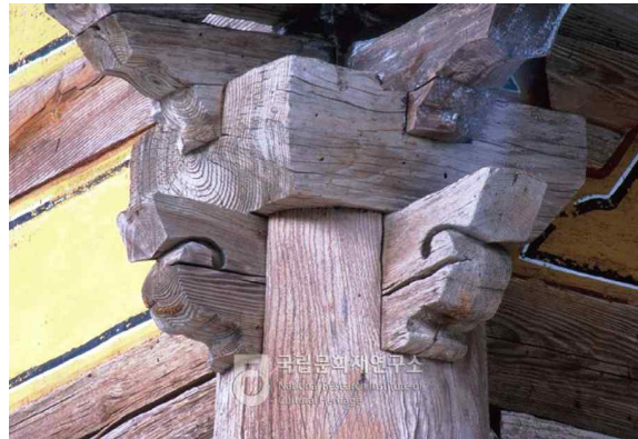
그림 24. 석왕사 응진당 공포 상세도(좌)와 무위사 극락전 창방뿔목 상세(우)
