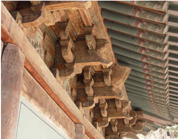
그림 25. 봉정사 대웅전 기둥의 편수깎기와 창방뿔목 상세도
