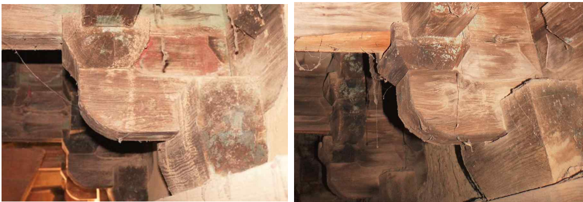
그림 10. 초제공의 마구리 형태(좌: 4번 공포의 원형 마감, 우: 10번 공포의 직철 마감)
